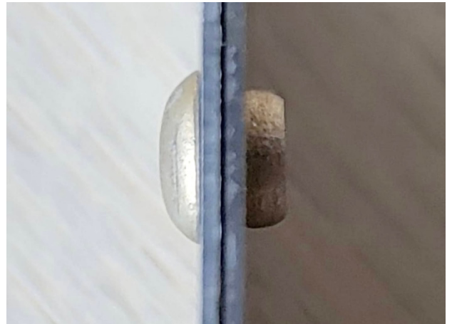
図 2 リベット結合部分
