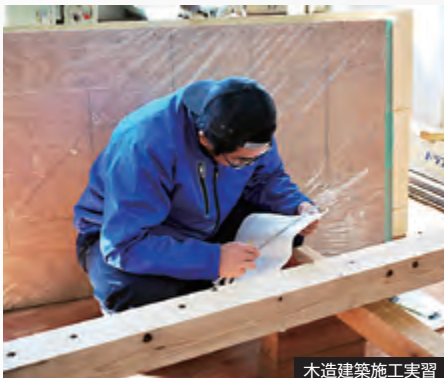
木造建築施工実習
