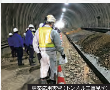
建築応用実習(トンネル工事見学)
