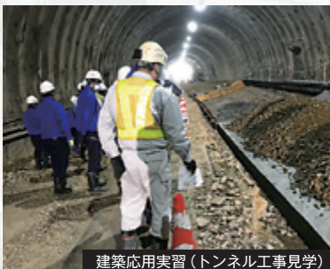
建築応用実習(トンネル工事見学)
